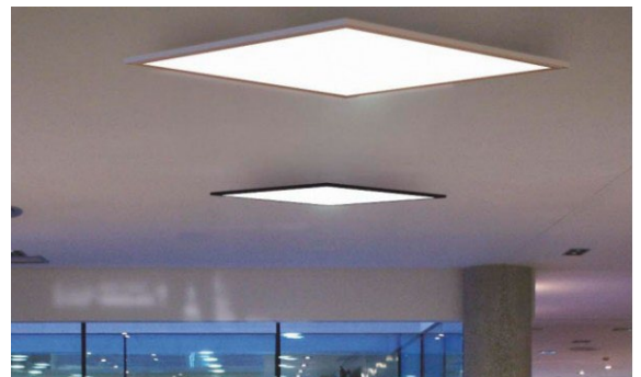
Las placas NUDEC®PMMA iFrost ofrecen un buen equilibrio entre la difusión y la transmisión de la luz, además de impedir que se vean los puntos de luz LED.
